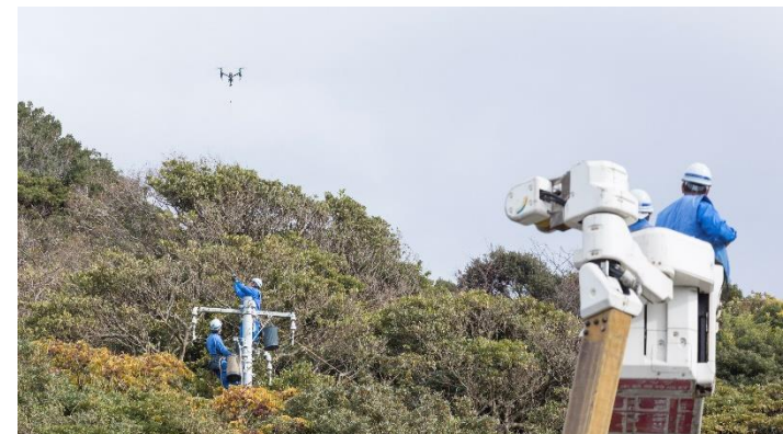
マルチコプタを活用したロープ延線作業の様子
